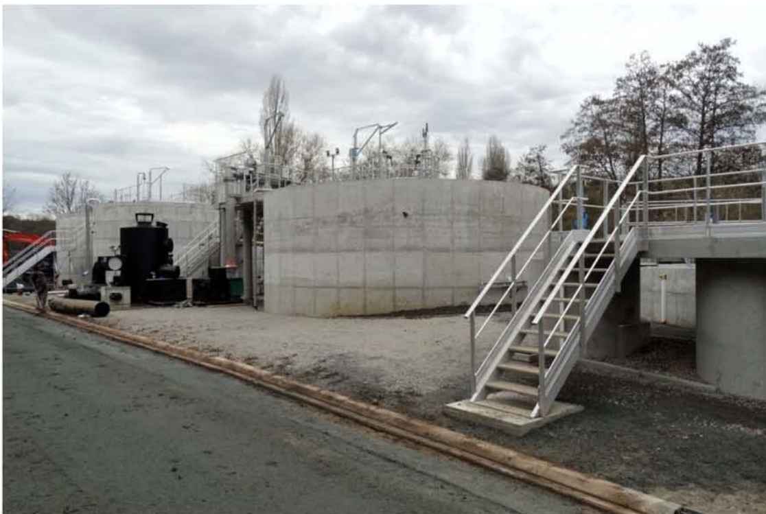
La nouvelle station d'épuration de Broglie dimensionnée pour 1476 équivalents habitants a été mise en service le 25 janvier 2024. ©Photo Eveil Normand/Philippe Wirton
