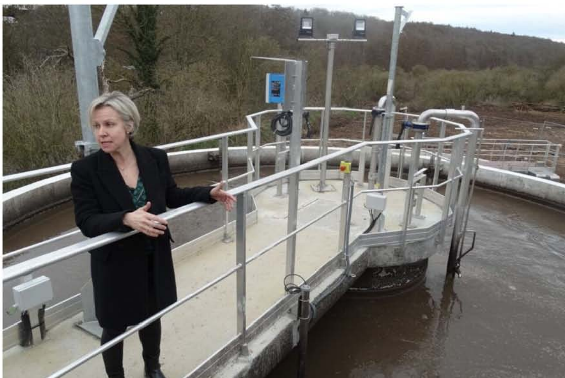
Anne Launay, technicienne Assainissement à l'IBTN, explique les différents cycles du traitement des eaux usées.
